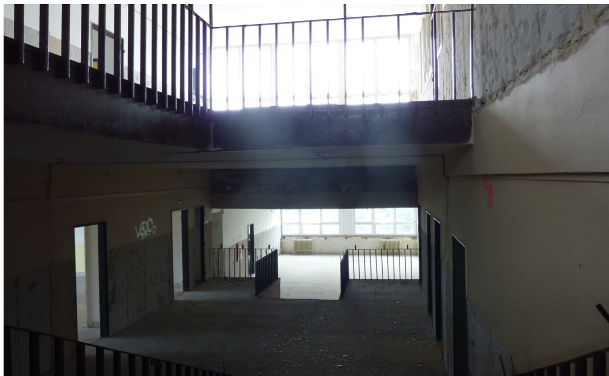
Pohľad na prepojovací krčok – dilatačný celok 3
