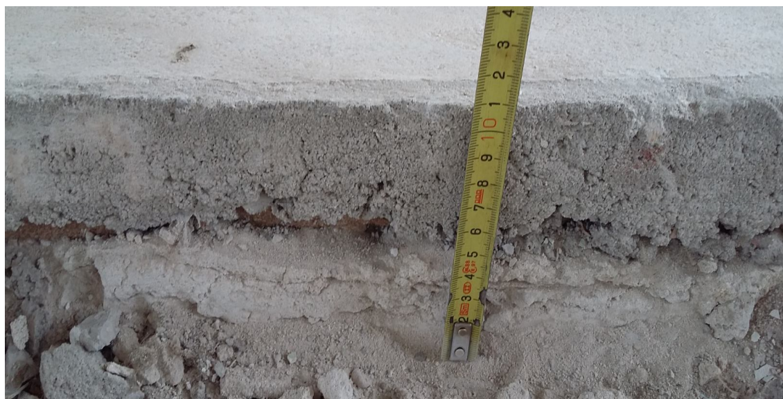
Obnažená výstuž stípa, bez betónovej zálievky
