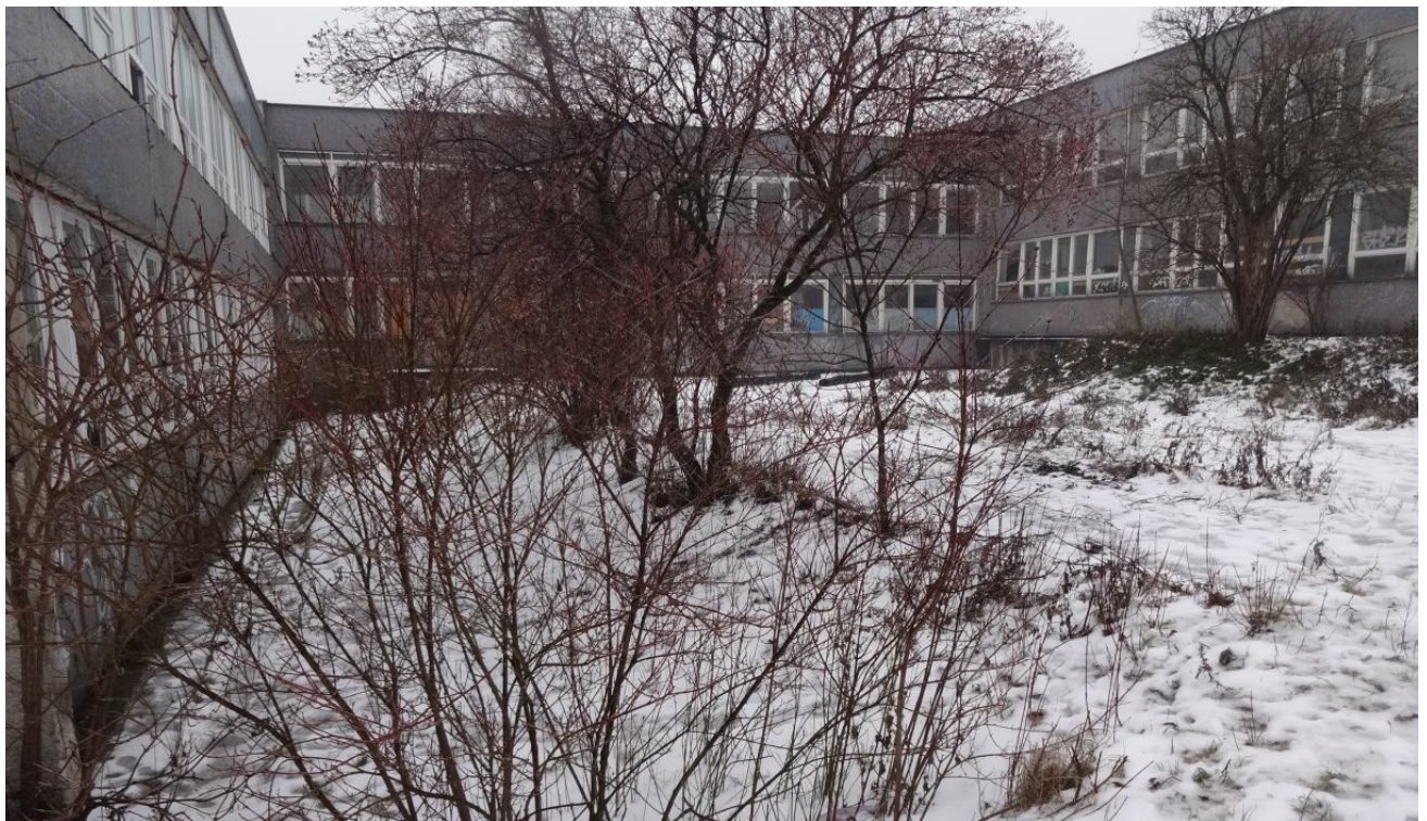
Pohľad na dilatačný celok 4, 1 a 2
