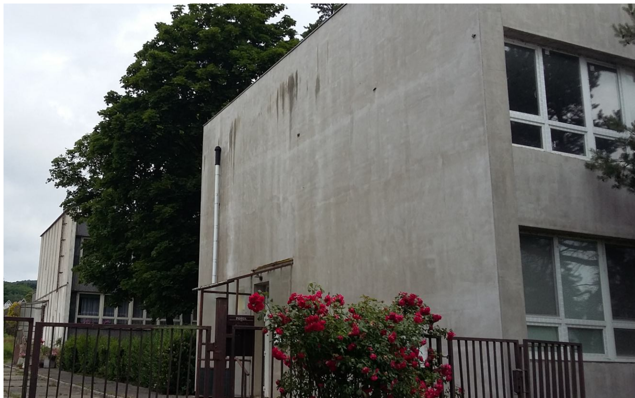
Pohľad na obvodový plášť
