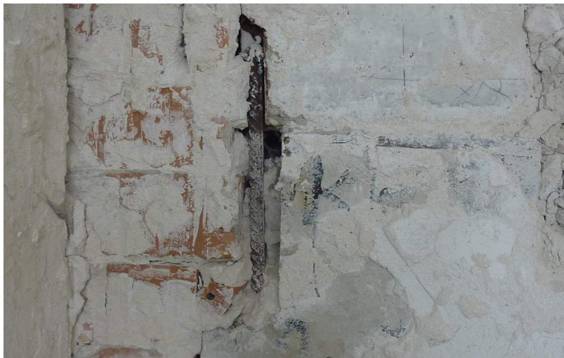
Obnažená výstuž stípa, bez betónovej zálievky
