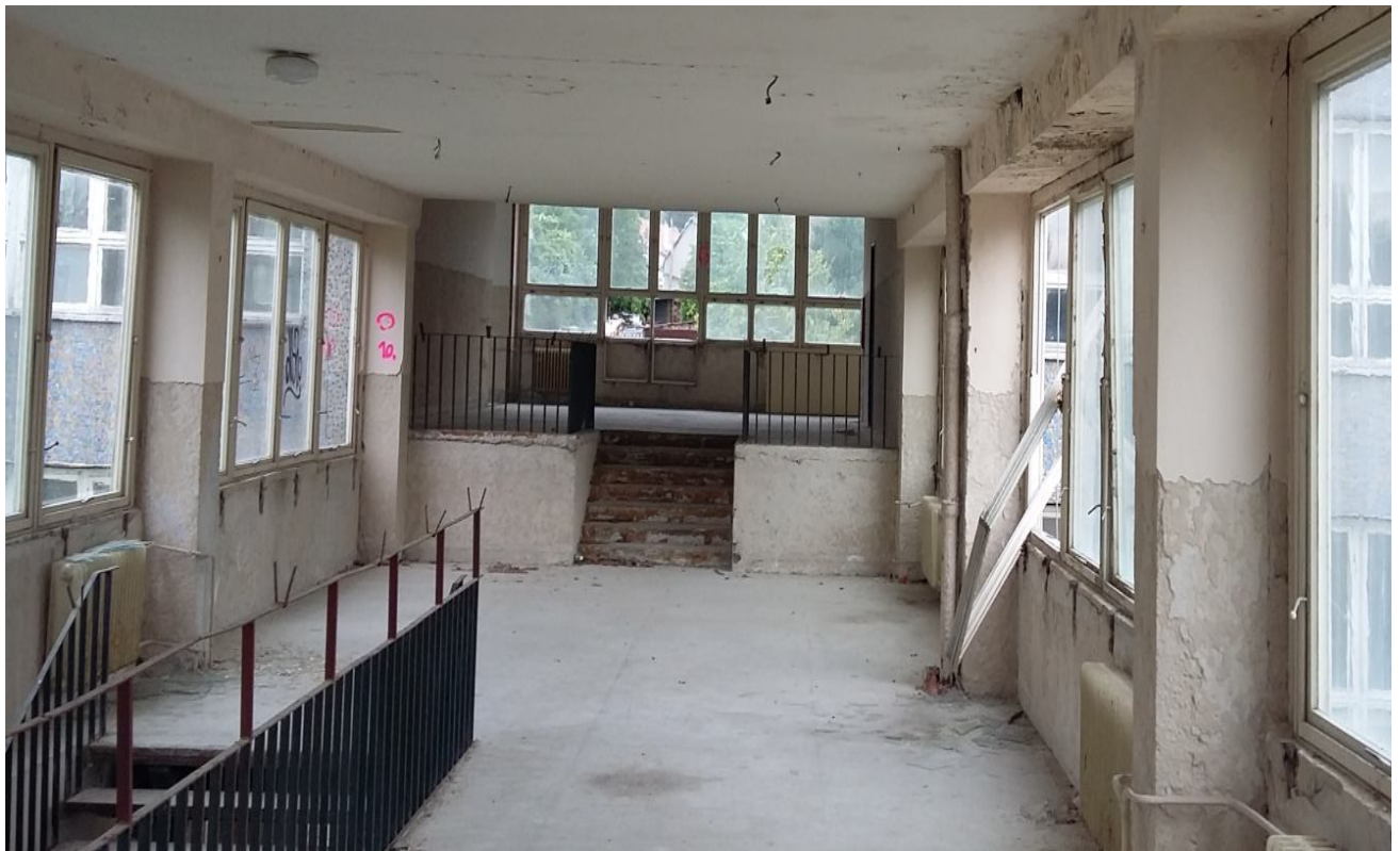
Pohľad na prepojovací krčok – dilatačný celok 4
