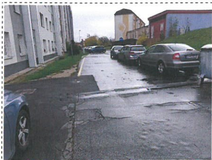
Prístupová cesta z JZ strany
