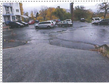
Pohľad na pozemok smerom JV
