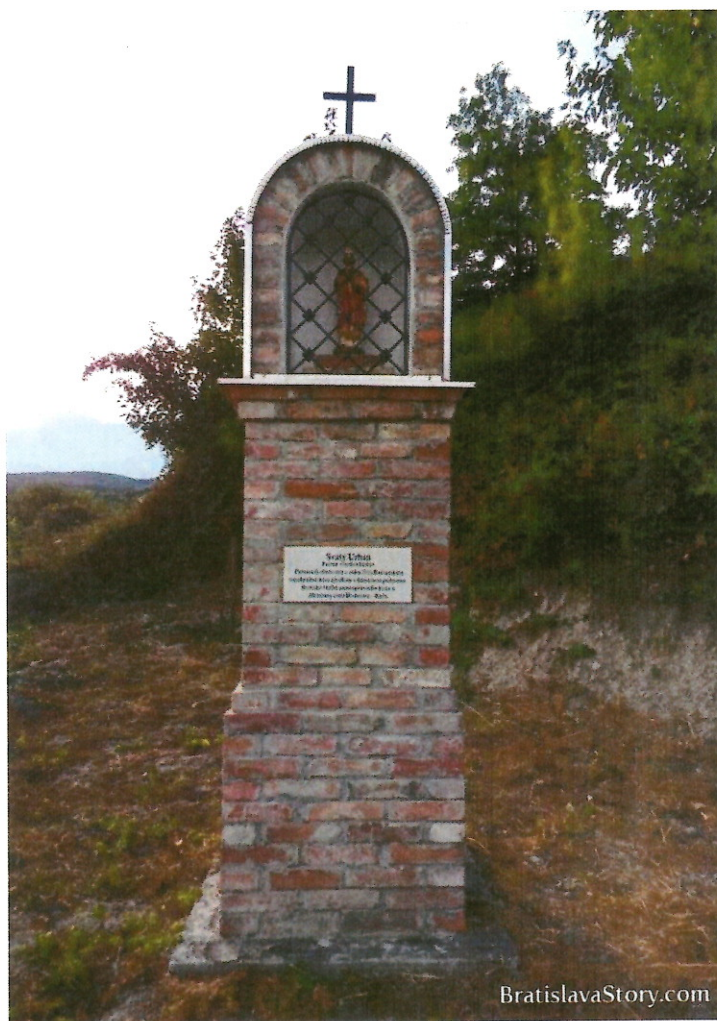
Božia muka sv. Urbana patróna vinohradníkov pred a po rekonštrukcii.
