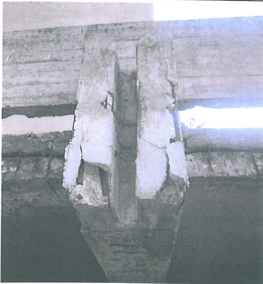
Poškodenie vonkajších častí nosných konzol, konzol zábradlia a okraja dosiek
