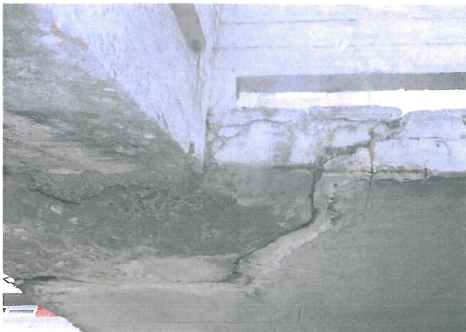
Devastačné poškodenie schodišťa a železobetónovej dosky terasy
