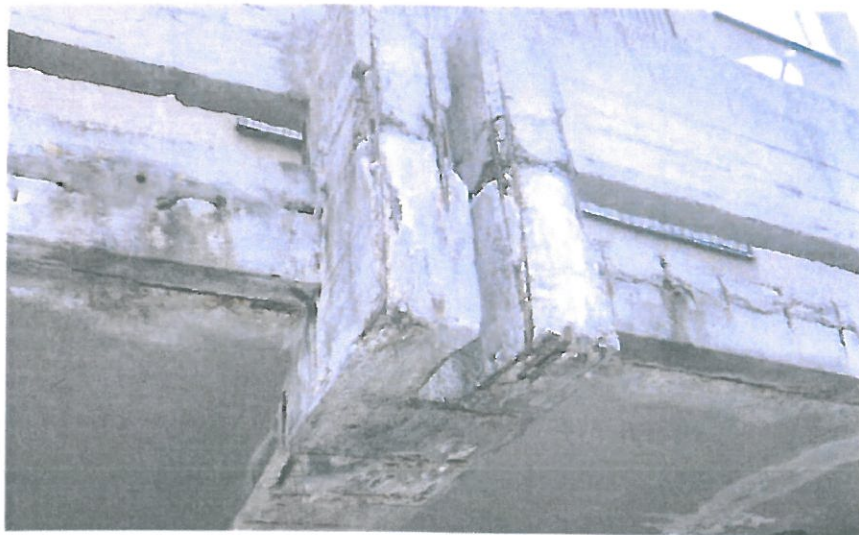
Poškodenie vonkajších častí nosných konzol, konzol zábradlia a okraja dosiek
