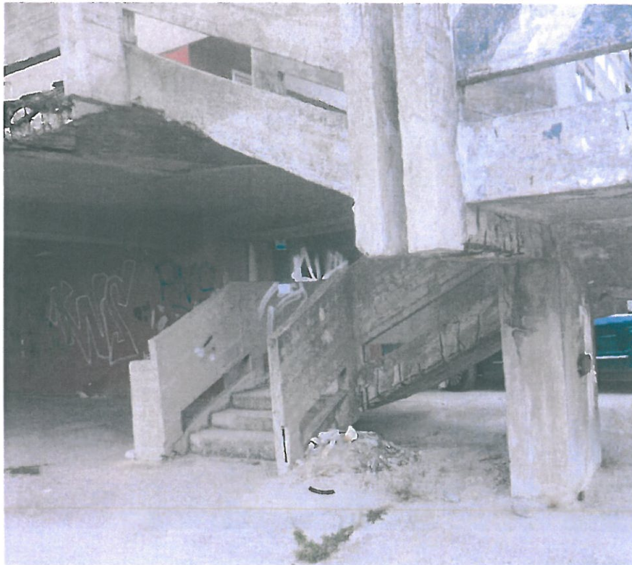
Devastačné poškodenie schodišťa a železobetónovej dosky terasy
